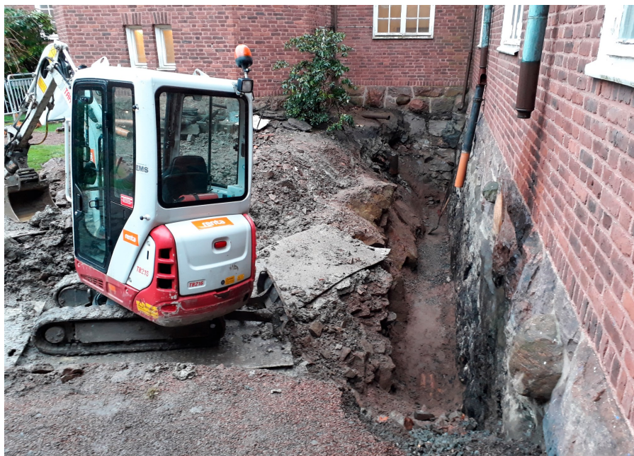
Dräneringsarbetet på museets innergård. Foto: Åsa Holmberg.
