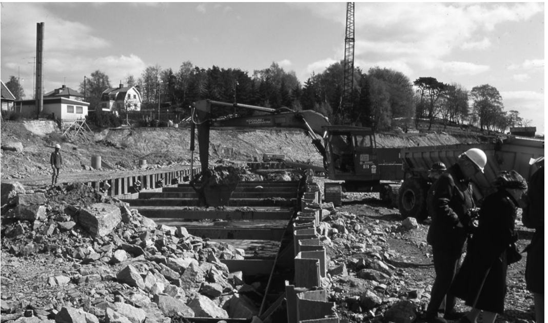
GNM 7033: 141. Arbete med förstärkning av skredområdet. Göteborgs kommun, Tuve, maj 1978. Foto: Åke Hillefors.
