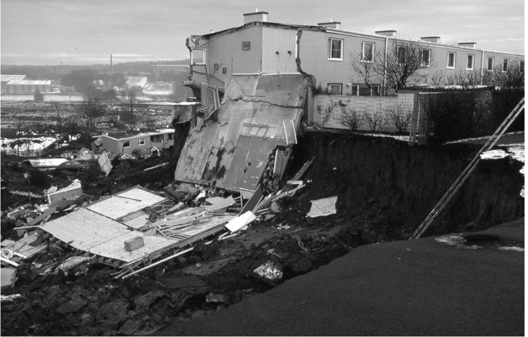
GNM 7033:52. Skredärr. Göteborgs kommun, Tuve, feb. 1978. Foto: Åke Hillefors.
